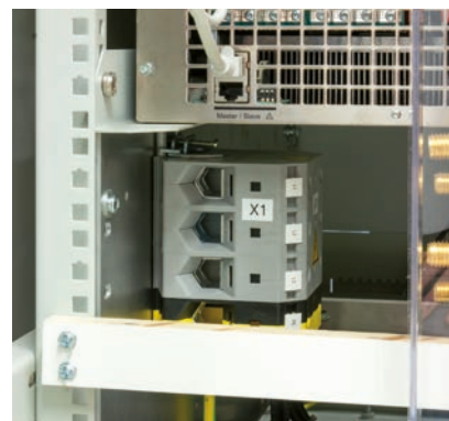
Входной АС терминал / AC input terminal
