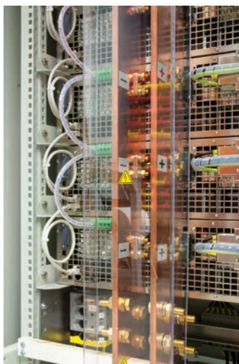
Шина DC терминала / DC bus terminal
